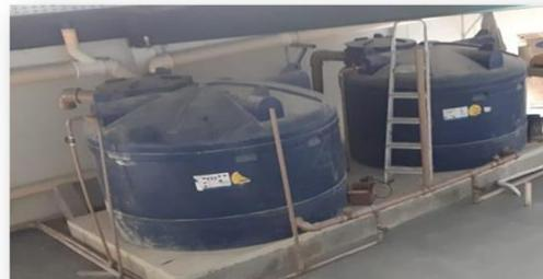
A água proveniente da chuva é armazenada em recipientes próprios e usada para lavagem da fábrica
